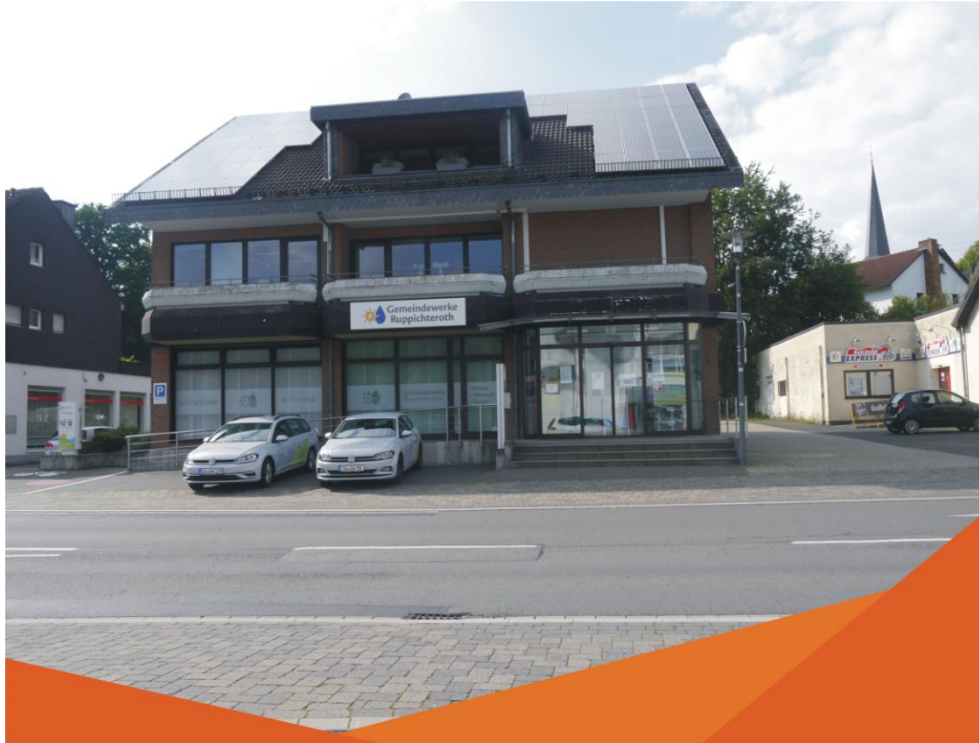
Geschäftsräume der Gemeindewerke
